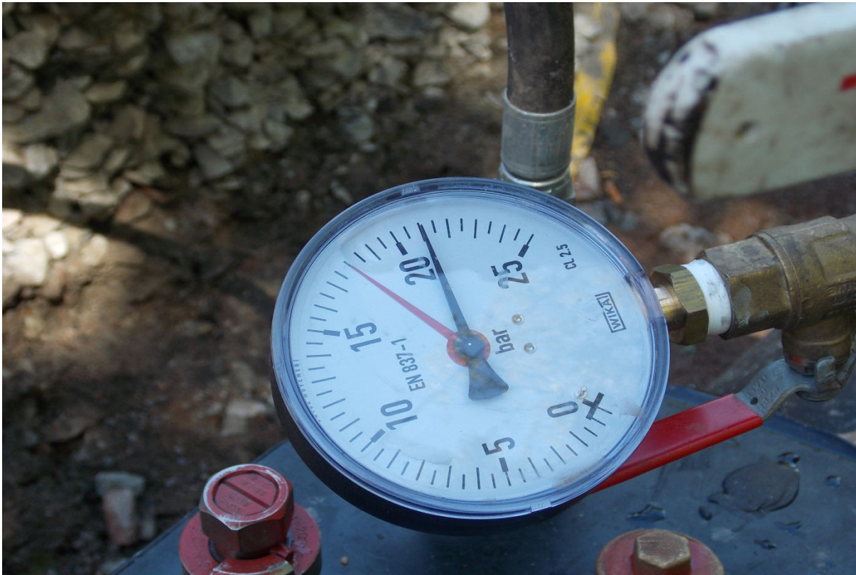
Uuden putkilinjan koeponnistus
