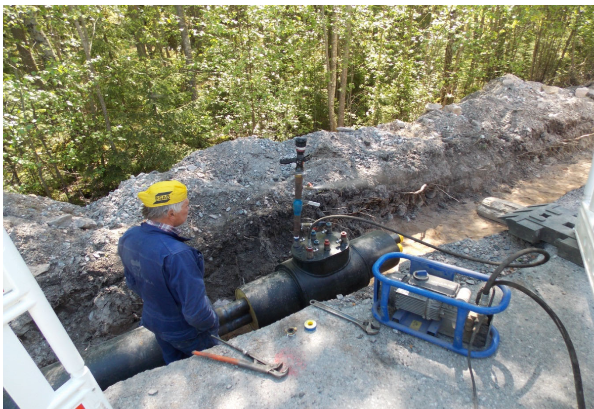
Provtryckning av Norrby fjärrvärmelinjen
